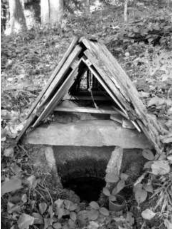
„Pod Jelení skalou“
