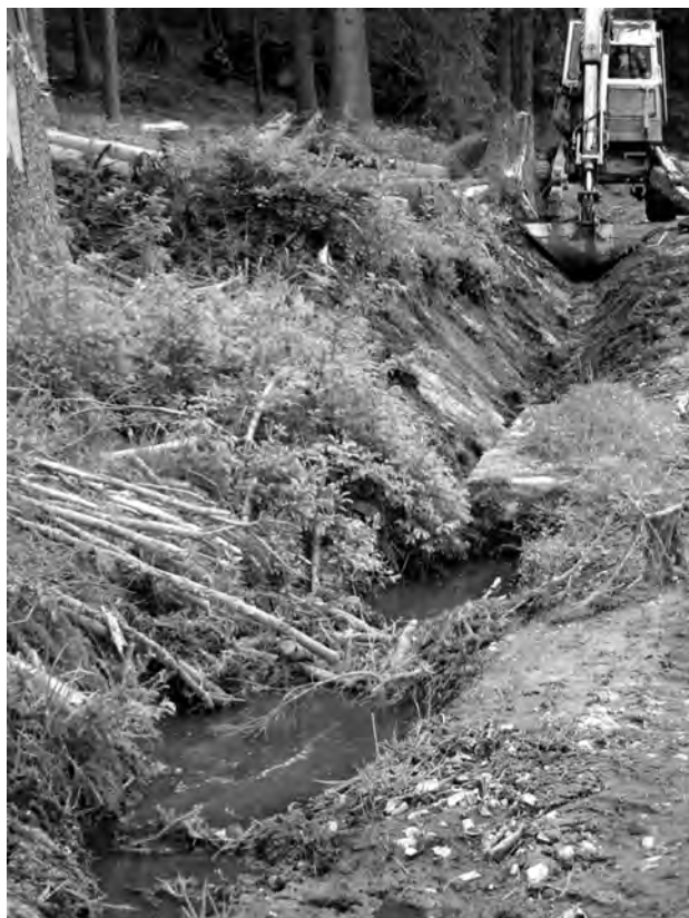
Obr. 4: Údržba podélného odvodnění
