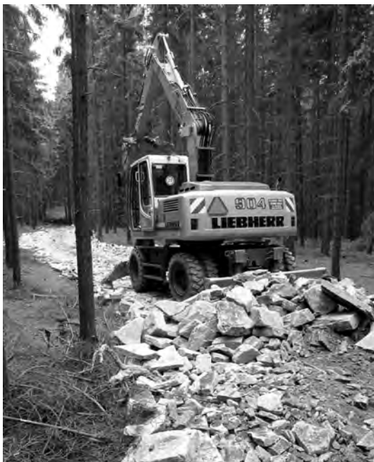
Obr. 1: Lesní cesta Pánov – zemní práce
