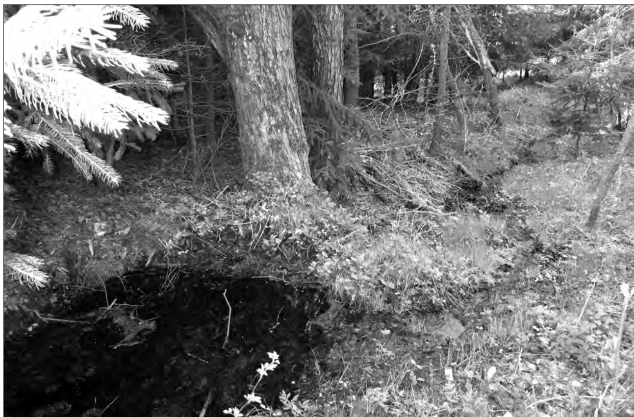
Vyvrácený strom v odvodňovacím příkopu vytvořil jezírko a brání odtoku vody
