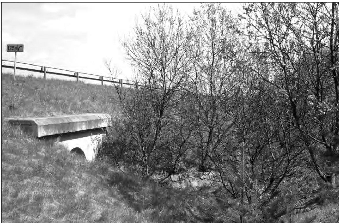
Nálety podél odvodňovacího příkopu před propustkem
