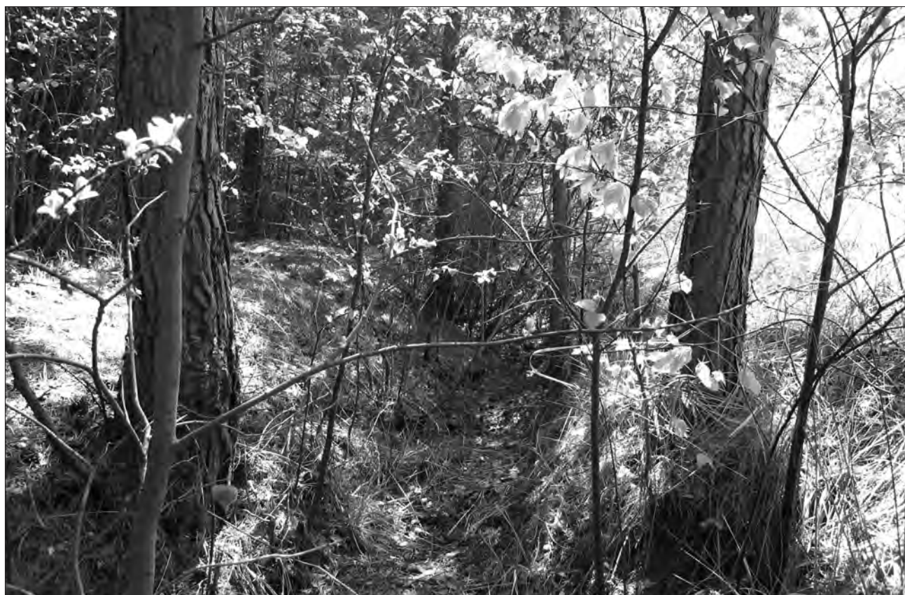
Zarostlý odvodňovací příkop
