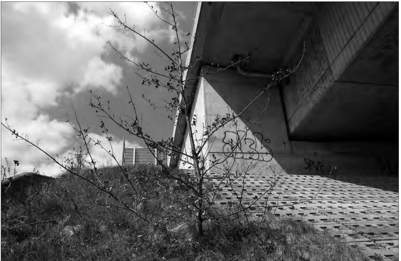
Nálet dubu v otvoru vegetační tvárnice pod mostem
