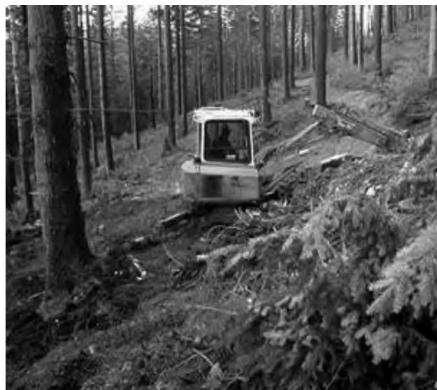
Obr. 4: Zemní práce prováděné mechanizací, v pozadí těleso stezky
