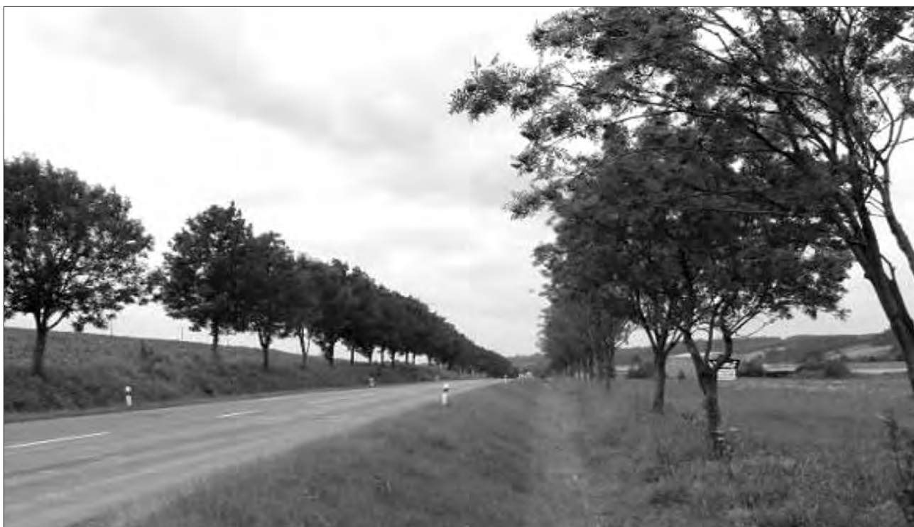
Aleje v dostatečné vzdálenosti od silnice. Stromy jsou však příliš blízko u sebe.
